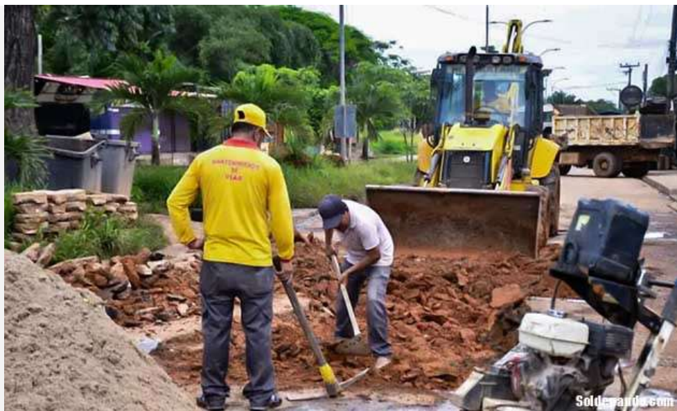
Este despliegue municipal se efectúa enteramente con recursos propios de la Alcaldía, mientras el Fondo Nacional de Inversión Productiva y Social (FPS) vaya encaminando contratos con empresas constructoras en un conjunto de 22 proyectos convenidos con el municipio de Cobija para rehabilitar todas las vías urbanas que colapsaron tras las inundaciones. | Foto Sol de Pando
