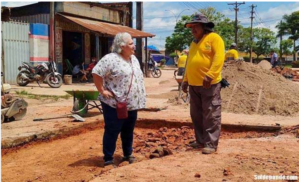
En previsión a la emergencia del próximo periodo de lluvias, la Alcaldesa ha dispuesto desde la semana pasada el bacheo y resellado de las principales vías de la ciudad, con maquinaria y recursos propios provenientes del ingreso municipal que genera el perdonazo tributario. | Foto Sol de Pando
