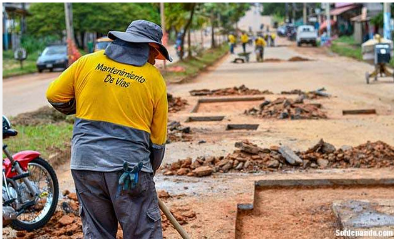
Los trabajos preventivos a cargo de la Unidad de Mantenimiento de Vías de la Alcaldía, además del bacheo, incluyen limpieza de alcantarillas y bocas de tormenta en las arterias conectadas con la avenida 9 de Febrero.
