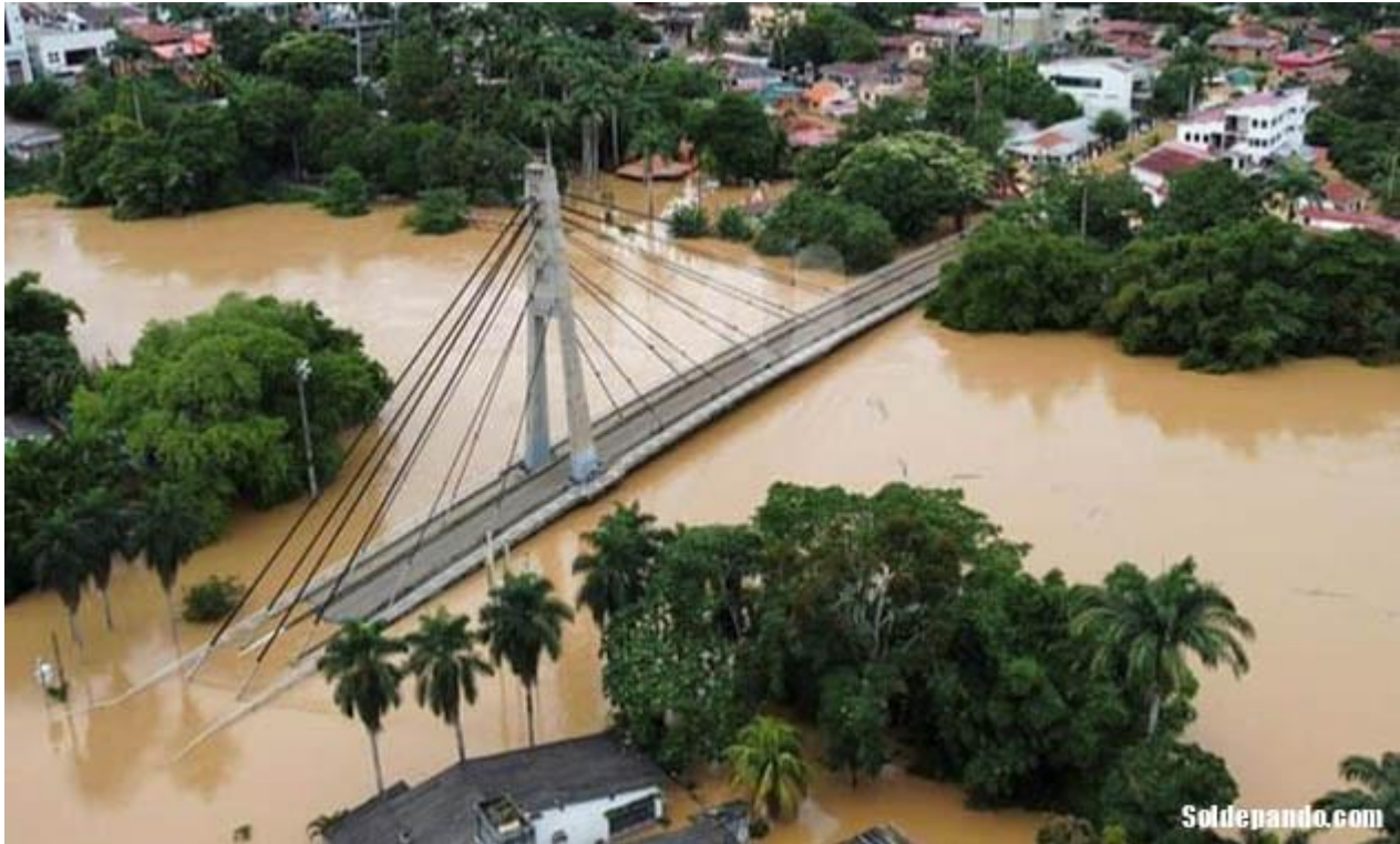
El emblemático Puente de la Amistad que une a las ciudades de Cobija y Brasiléia, quedó sumido bajo las aguas del Acre cuando el nivel máximo del desborde rozó los 16 metros. | Foto Sol de Pando
