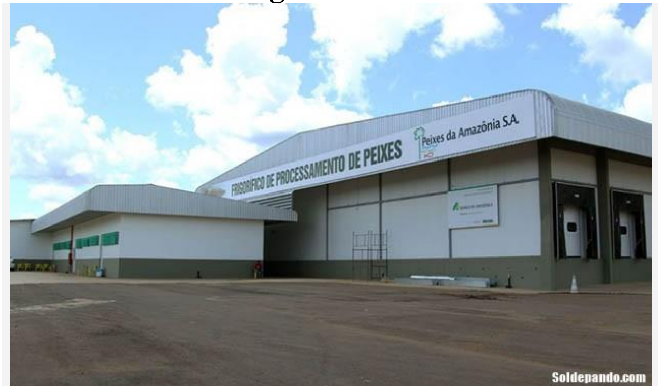
Las cámaras refrigerantes de "Peixes da Amazonia" se encuentran sobre la carretera BR364, punto estratégico que permitirá su distribución desde Rio Branco a los demás 21 municipios acreanos. La planta se hallaba paralizada desde hace dos años. | Foto AC24Horas
